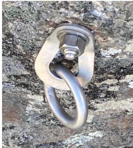
Figura 3.7 - Nova parada nas vias da Pedreira
