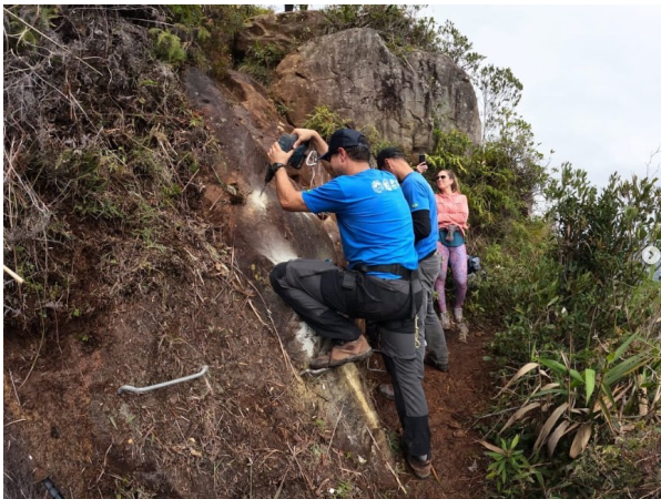
Figura 5.4 - Instalação de degraus
