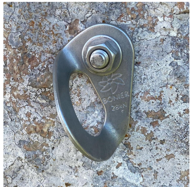
Figura 3.6 - Chapeleta nova instalada.
