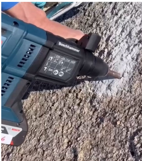
Figura 3.8 - Instalação do grampo de titânio
