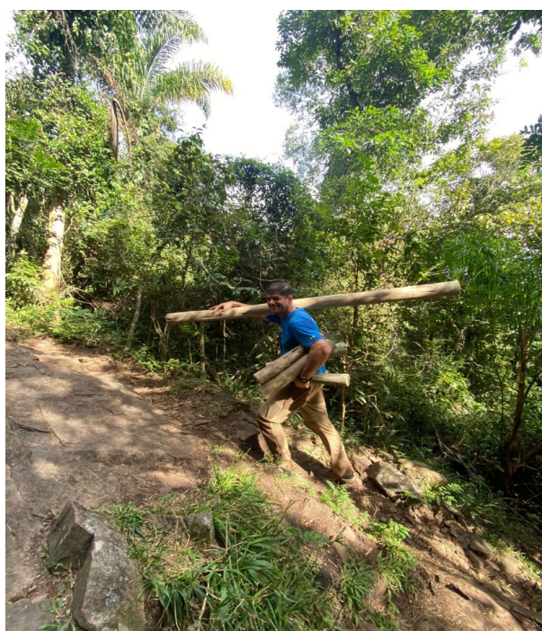
Figura 5.3 - Manutenção de acessos
