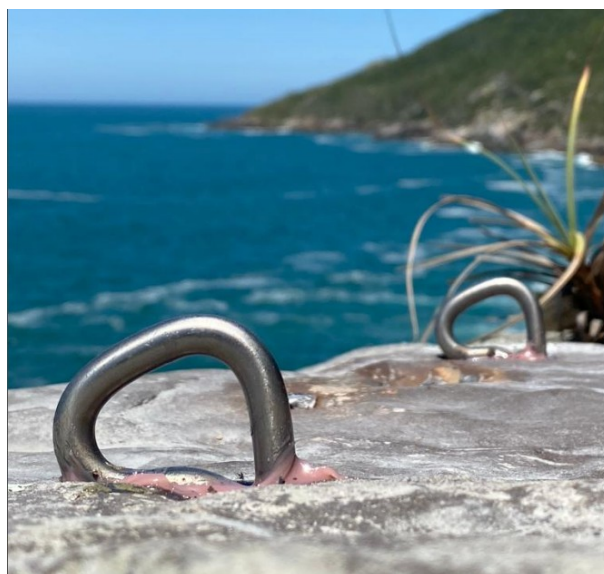
Figura 5.8 - Grampo de Titânio instalado
