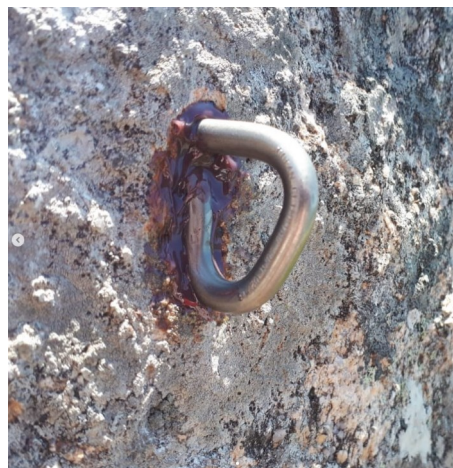
Figura 3.3 - Grampo de titânio instalado.
