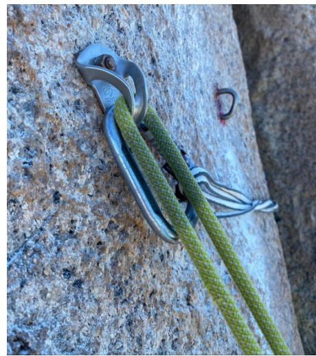
Figura 3.9 - Grampo de titânio instalado.
